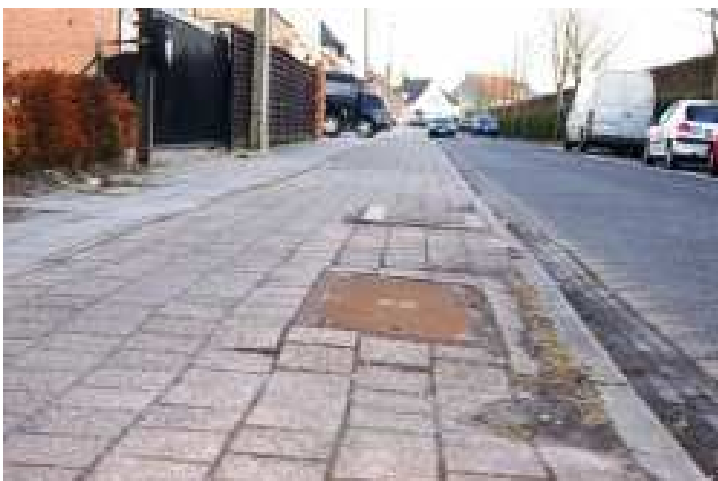
Fietspad Jan Hammeneckerstraat, Mariekerke
